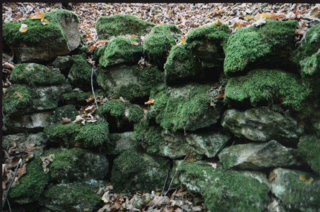
Zidul unei construcții mici din piatră, aflat pe vârful dealului Osoi. Localitatea Vadu Izei Zidul din piatră are 2 m lungime, 1,7 m lățime și 1,2 m înălțime.
