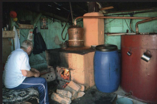
Instalații tehnice acționate de apă (moară, piuă, vâltori) și cazane „La moară la Niculai”
